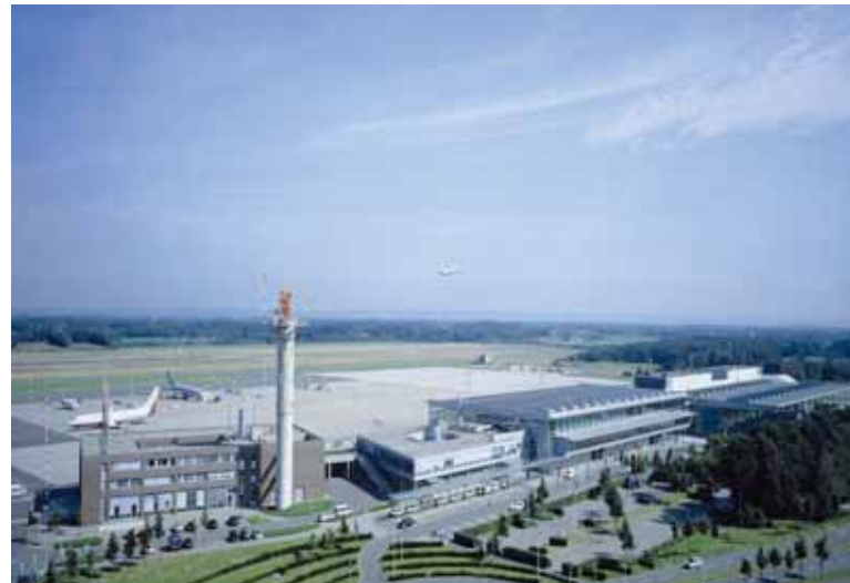
Direkt vor dem Flughafen Münster/Osnabrück entsteht der neue AirportPark
